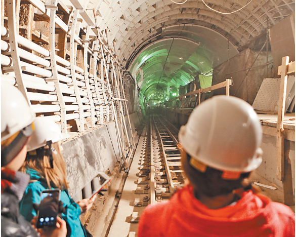
Работы на участке Люблинско-Дмитровской линии метро ведутся круглосуточно, в них заняты 4 тысячи рабочих.
